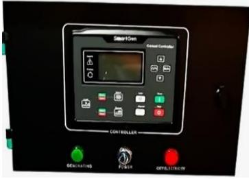
Controlador de falla de red automática para un solo generador, puede monitorear y proteger el generador en funcionamiento todo el tiempo. Tiene una pantalla LCD que muestra claramente el estado del motor. Este controlador incluye siete entradas y seis salidas. Este controlador también se puede programar usando el panel o usando el software de configuración Suite.
