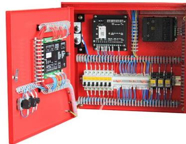
Deepsea 6120 es un controlador de falla de red automática para un solo generador, puede monitorear y proteger el generador en funcionamiento todo el tiempo. Tiene una pantalla LCD que muestra claramente el estado del motor. Este controlador incluye siete entradas y seis salidas. Este controlador también se puede programar usando el panel frong o usando el software de PC DSE configuration Suite.
